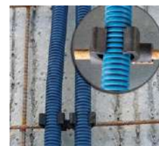
POSA A PAVIMENTO ARMATURE
